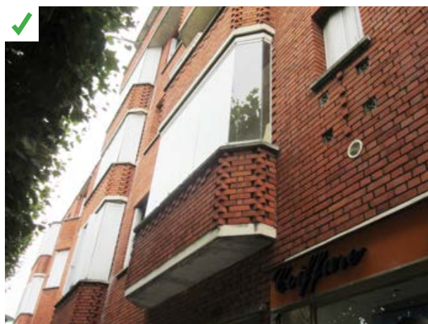
Les loggias ont été vitrées pour réaliser un jardin d'hiver et permettre une amélioration du confort thermique et acoustique. Le confort d'été n'a pas été dégradé grâce à la présence des arbres à feuilles caduques le long de la façade. ©AQC
