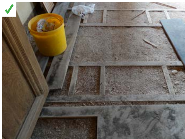
L'ensemble du remplissage existant (gravas, sable, plâtre) entre solives a été cureté. Un isolant à base de fibres végétales a été mis en œuvre en remplacement afin de répondre aux besoins thermiques et acoustiques. ©AQC
