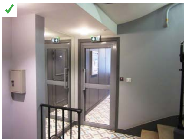
La cage d'escalier, espace non chauffé, était séparée de la rue par une porte cochère monumentale, non isolée. Un sas d'entrée a été créé. Le confort thermique, acoustique et la sécurisation de l'immeuble sont ainsi améliorés. ©AQC
