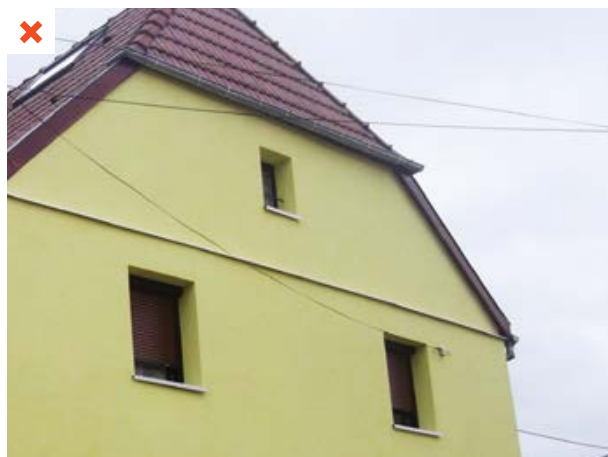
Cette maison traditionnelle en assemblage pierre et colombage a été isolée par l'extérieur. Les ouvertures de baies ont été réduites, les volets en bois ont été remplacés par des volets roulants, les modénatures existantes ne sont plus visibles. L'intérêt patrimonial de cette maison a disparu. ©AQC
