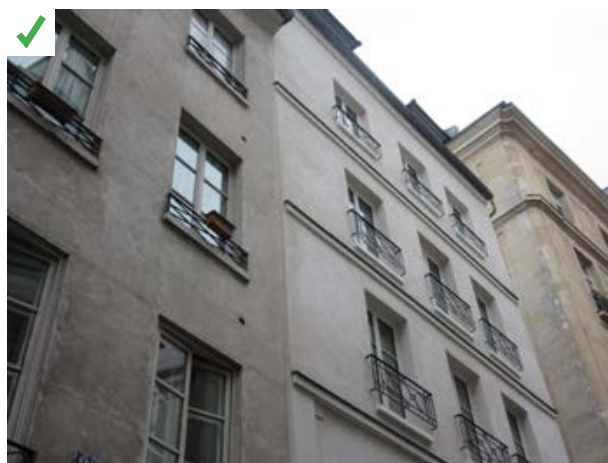
Pose en extérieur d'un enduit chaux chanvre protégé par un enduit de finition chaux sable. En intérieur, la pierre est habillée d'enduit chaux chanvre projeté, recouvert d'un enduit de finition à la chaux. Les interstices entre les pans de bois ont été curetés du plâtre. Un isolant en fibres végétales a été inséré à la place en remplissage et des panneaux d'isolant en fibres végétales haute densité ont été fixés de part et d'autre de l'ossature en pan de bois. ©AQC
