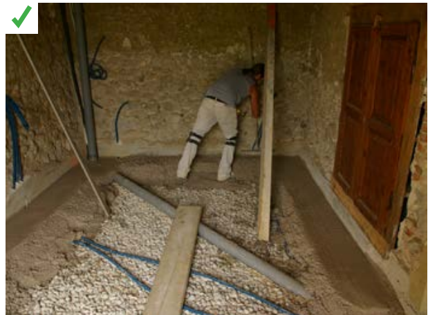
Traitement thermique du soubassement du mur par l'intérieur au moyen d'une dalle en béton de chaux-pouzzolane. Celle-ci repose sur un hérisson sur drain ventilé. ©AQC
