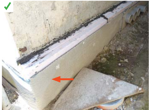
L'isolation du soubassement a été réalisée par la mise en place d'un isolant imputrescible. ©AQC
