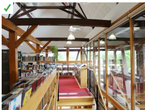
Les soubassements, la toiture et les parois ossature pan de bois ont été conservés. Une nouvelle ossature largement vitrée a été mise en œuvre en retrait de la façade existante qui a été curetée de son plâtras. L'espace créé entre les parois permet la circulation et l'entretien.
