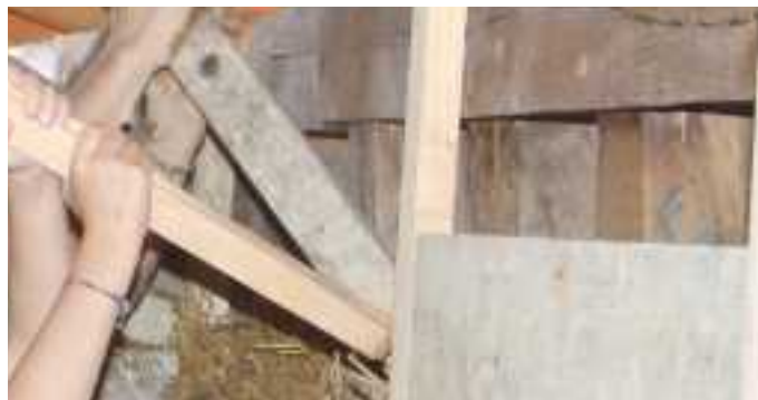
Le mélange est tassé avant la rehausse du coffrage.
