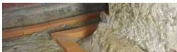
Pente à 45° non décaissée au pied du mur en pierre, et réseau de briques.
