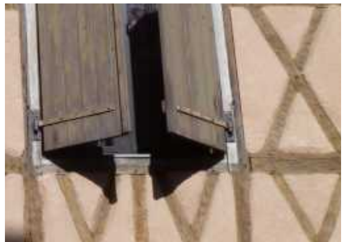
Mur terre crue et colombages.
