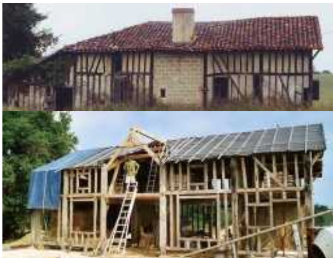
Avant et après la restauration du pan de bois.
