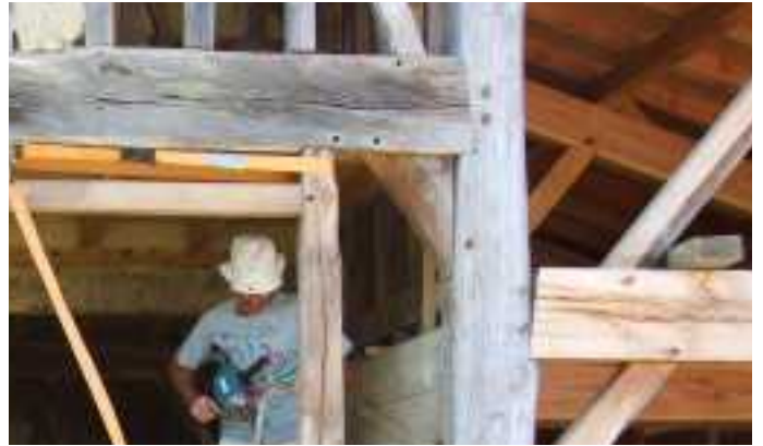
Le charpentier perce le trou de la cheville qui bloque l'assemblage en tenon-mortaise.
