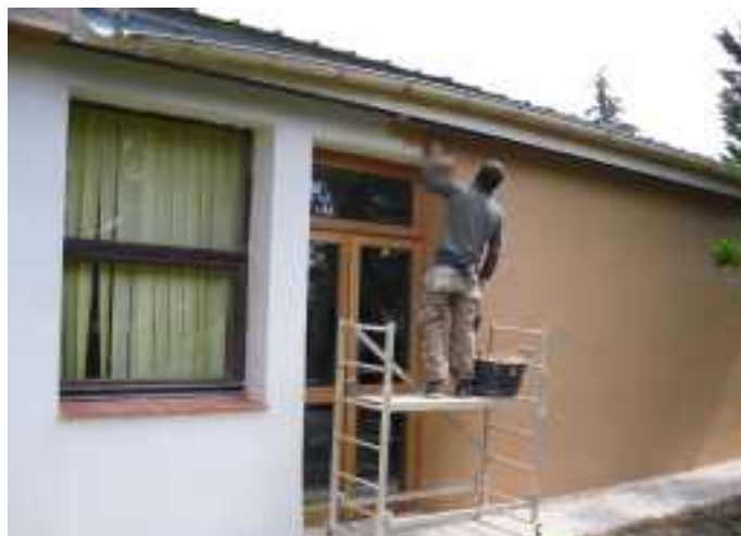
Application de l'enduit de finition coloré.
