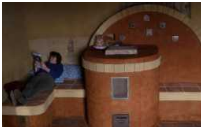
Le poêle de masse terminé, avec son enduit terre.
