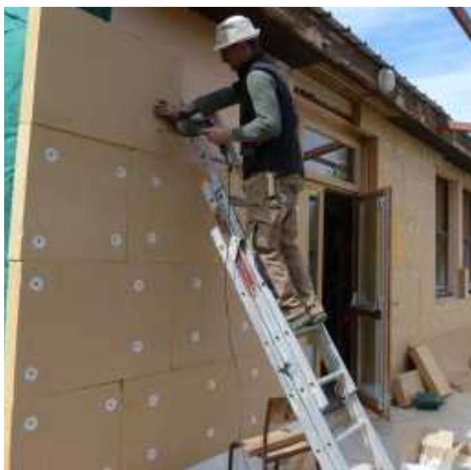
Fixation des panneaux de fibres de bois.
