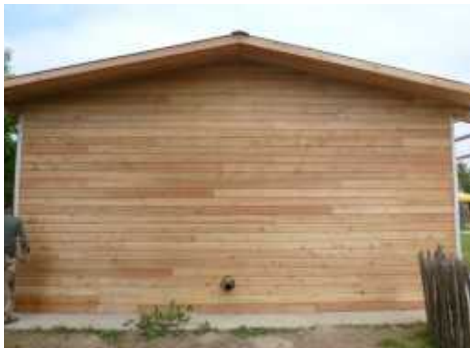
Aspect final de la façade : bardage bois horizontal.
