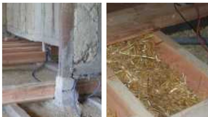
Solives sur les longrines & paille entre solives.
