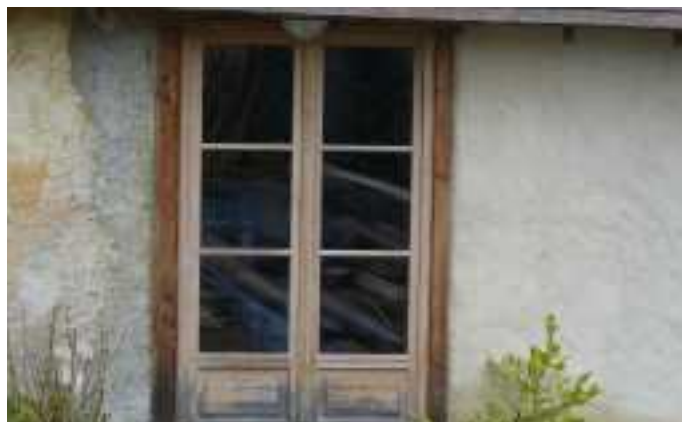
L'enduit chaux-sable laisse respirer le mur de pisé.
