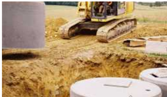
Mise en place des cuves sur lit de sable
