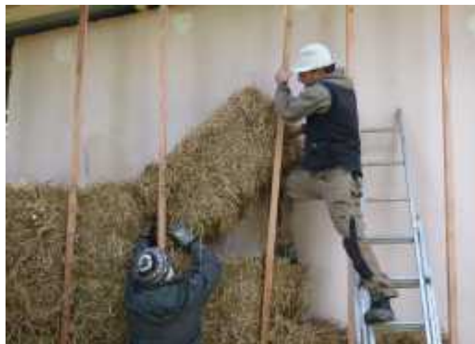
Mise en place des bottes de paille entre le mur et l'ossature.
