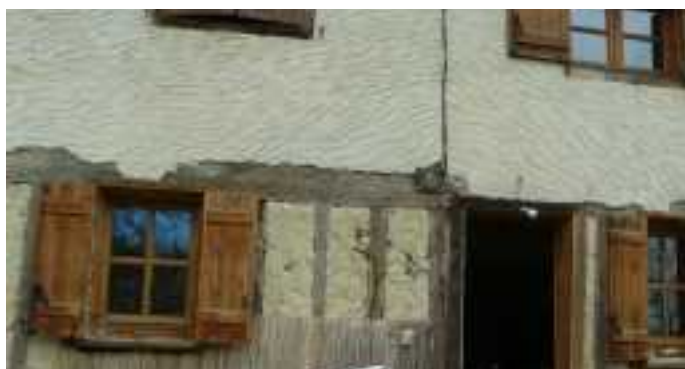
Enduit ciment recouvrant un mur en terre.
