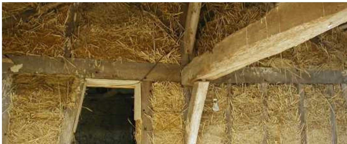
Ci-dessus : préparation d'un chantier terre-paille allégé. Ci-dessous : mur en terre-paille allégé.
