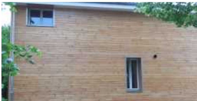
Façade ouest pendant et après travaux.
