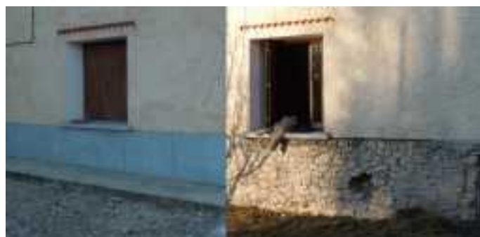
La façade avant et pendant les travaux.
