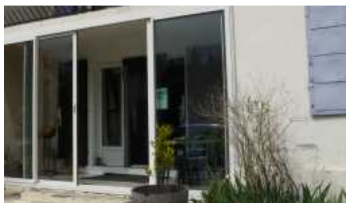
Avant et après installation de la baie vitrée.
