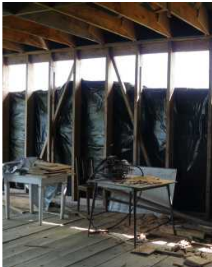
Ci-dessus : préparation d'un chantier terre-paille allégé. Ci-dessous : mur en terre-paille allégé.
