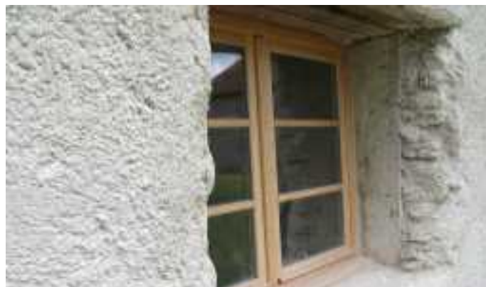
Enduit extérieur, finition enduit chaux aérienne-sable.
