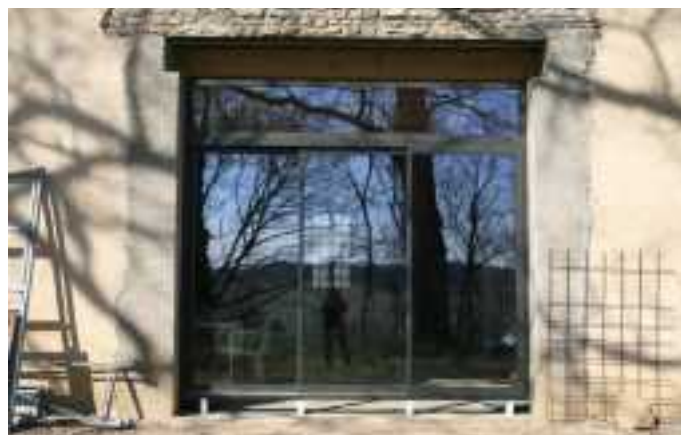
Création d'une grande ouverture au sud sur une maison ancienne.
