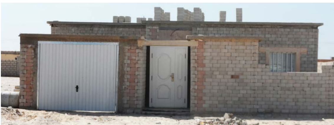
Maison BTC réalisée en 2014 dans le quartier Samia de Nouakchott / Source : Omar Wele
