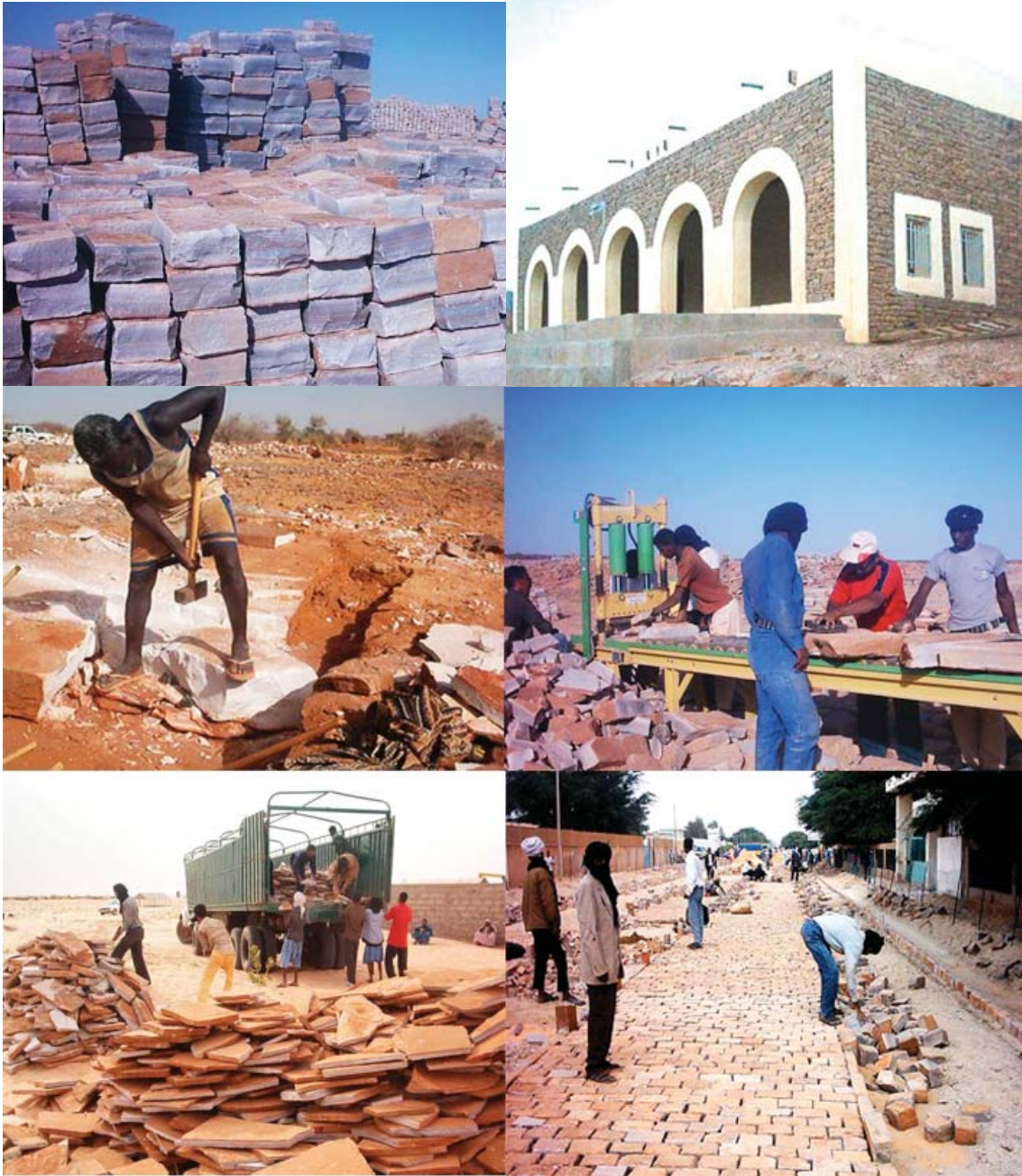
Extraction, taille, entreposage, transport, mise en œuvre de pierres de carrière par les GIE / Source : ETR-ML
