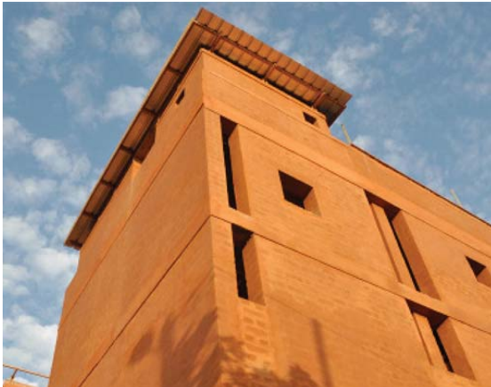
Deux exemples d'architecture durable très opposées : bâtiment en terre crue porteuse avec dalles béton réalisé à Dakar au Sénégal et bâtiment à ossature bois réalisé à Vitry en France / Sources : ELEMENTERRE (Sénégal) – CNDB (France).
