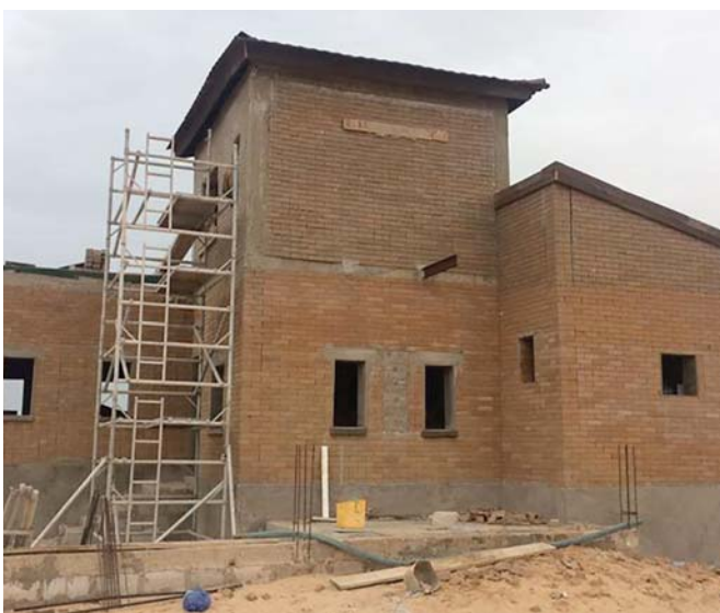
Maison BTC en cours de construction à 35km de Nouakchott / Source : Kebab Khawmany
