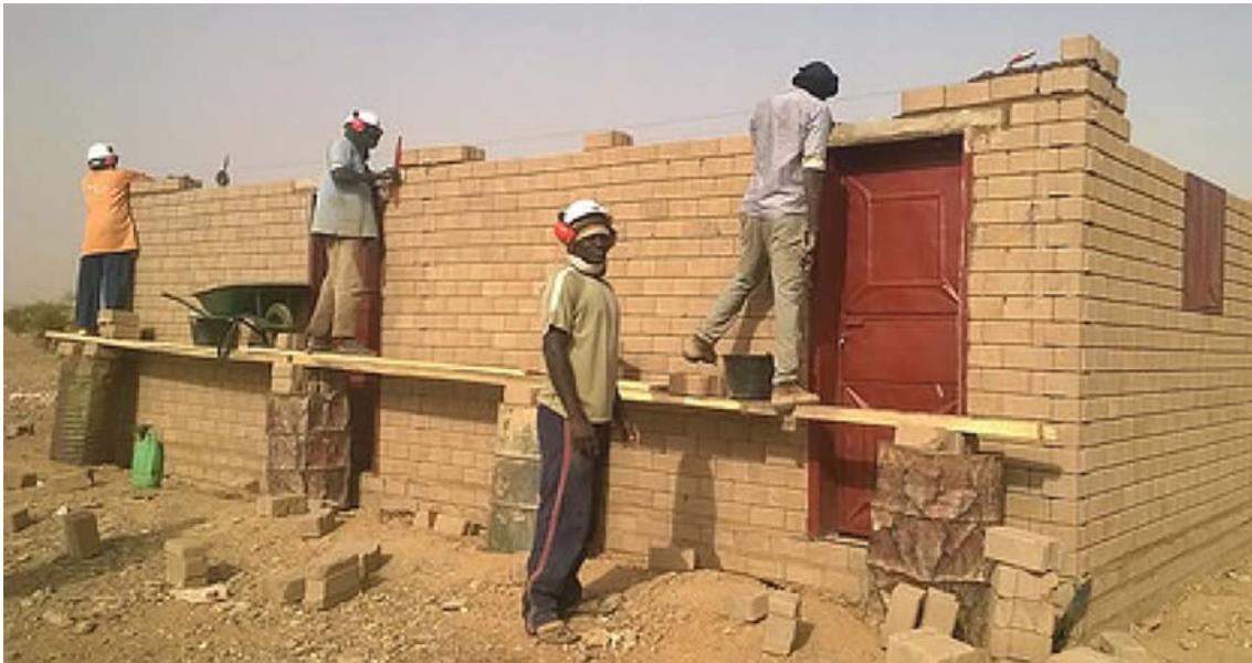
Chantier BTC avec formation de jeunes / Source : ECODEV
