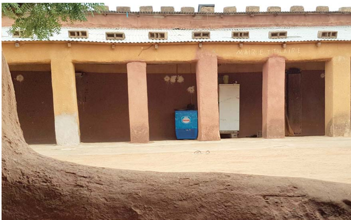
Bâtiment en terre recouvert de tôle importée – Village de Daffort - Guidimakha / Source : Mathieu Hardy
