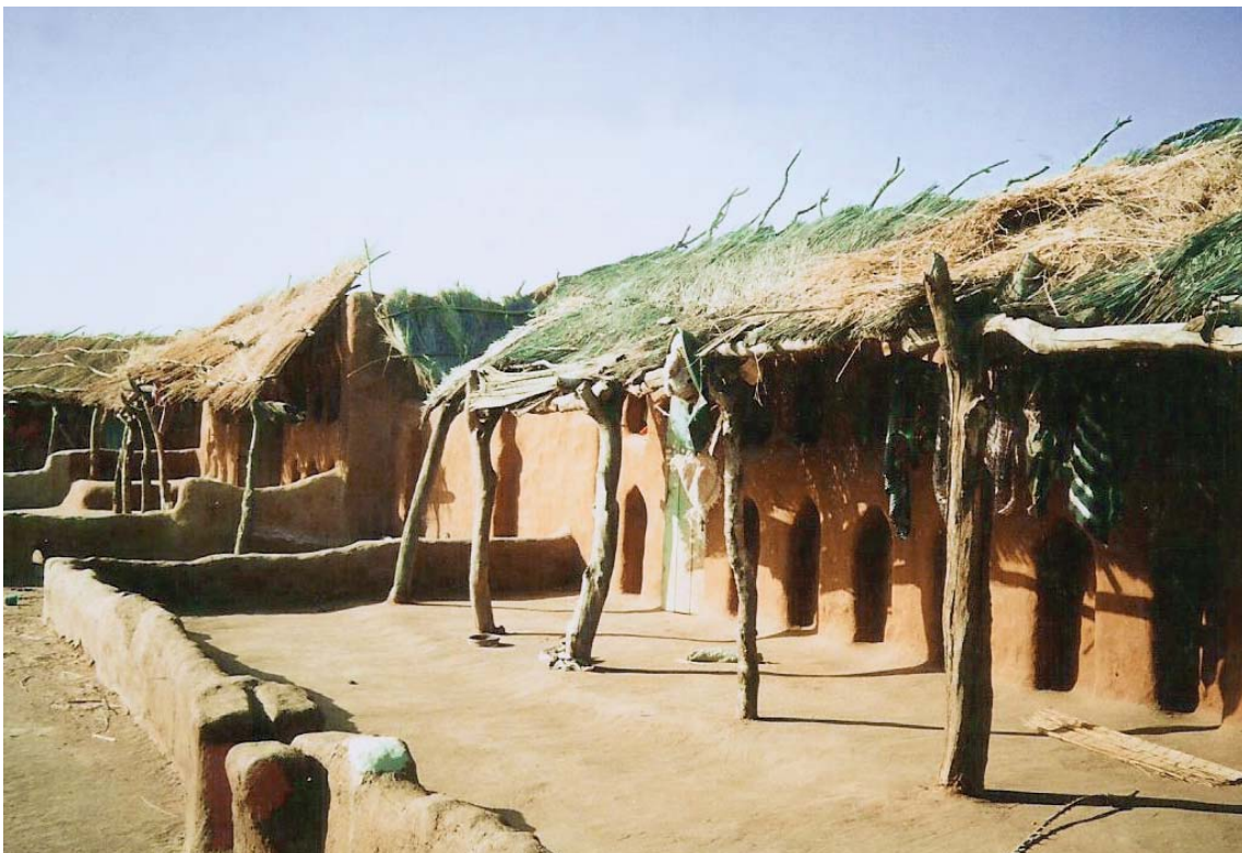
Vue des façades et auvents à l'intérieur d'une concession / Source : Tidiane Diagana
