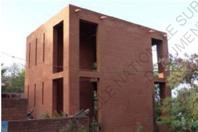
Chantier en BTC de L'Océanuim à Dakar
