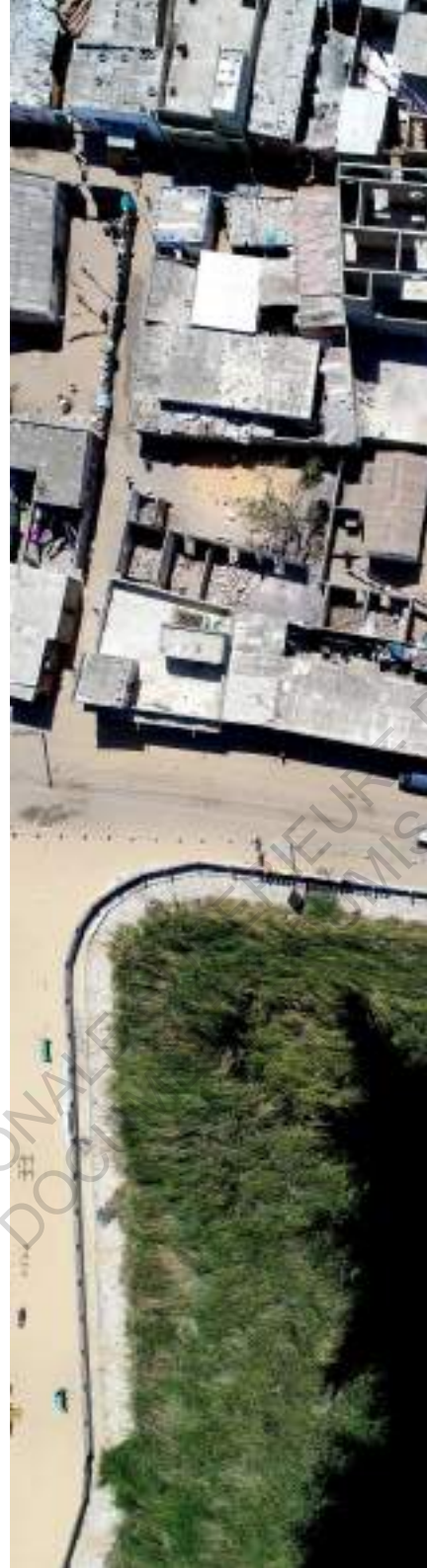
Bassin de rétention en partie envahit par le typha>
